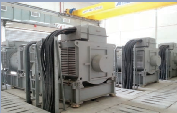
Pemasangan Frequency Converter bagi menampung keperluan bekalan kuasa darat bagi kapal TLDM yang merapat di PTKK
