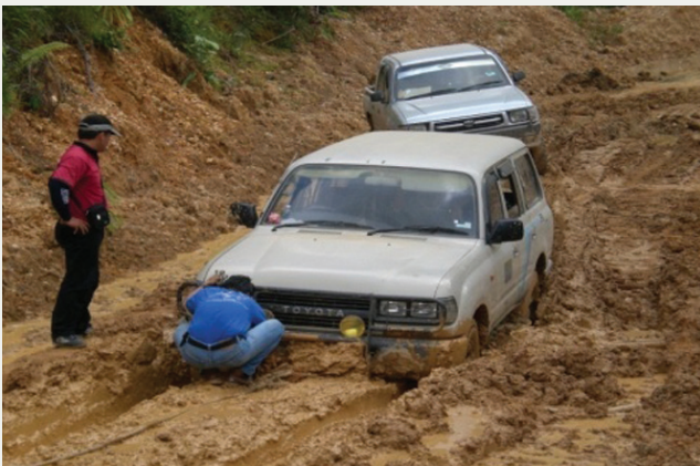
Gambar 3 : Keadaan jalan semasa pembinaan
