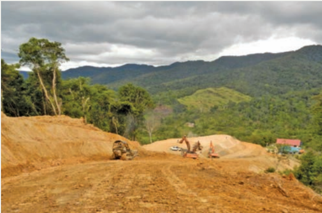
Gambar 1 : Keadaan jalan semasa pembinaan
