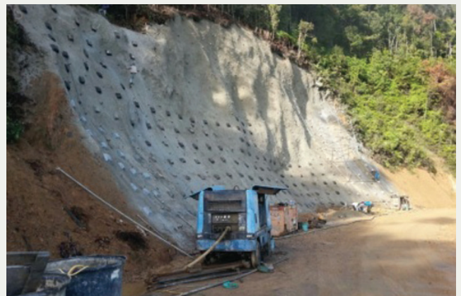
Gambar 2 : Keadaan tebing setelah siap pembaikan
